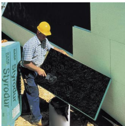
Bild 8/5: Die Perimeterdämmplatten werden mit Bitumenkleber aufgeklebt.
