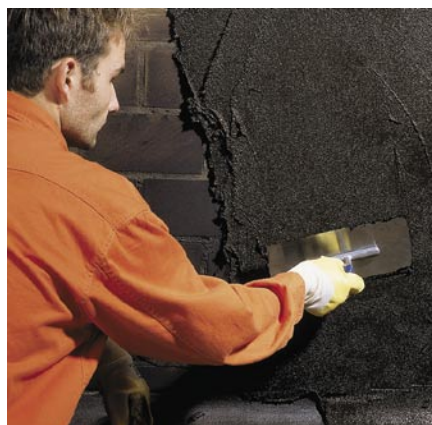
Bild 6/5: Aufziehen der kunststoffmodifizierten Bitumendickbeschichtung (KMB)
