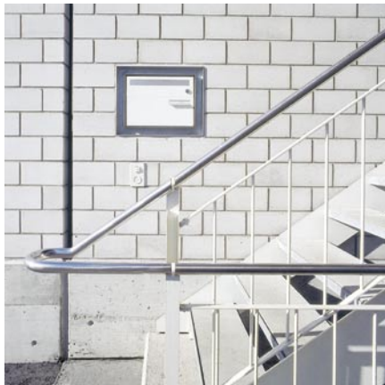
Bild 3/14: Innensichtmauerwerk aus kleinformatigen Kalksandsteinen
