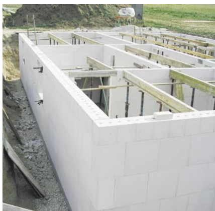
Bild 4/5: Kalksandstein-Mauerwerk ist für den Kellerbau bestens geeignet.
