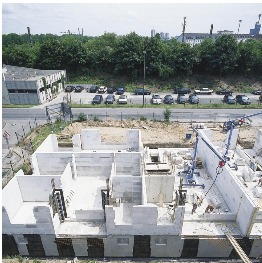
Bild 9/2: Kellerwände aus Kalksandstein sind wirtschaftlich und sicher.
