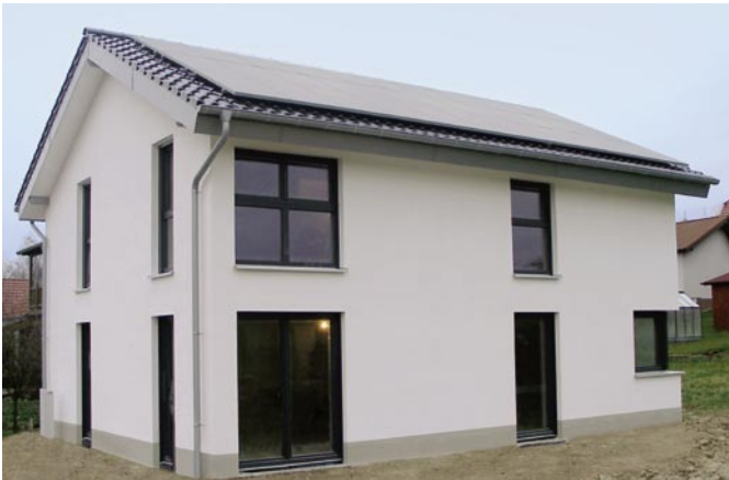
IQ++Energiespeicherhaus in Körle
