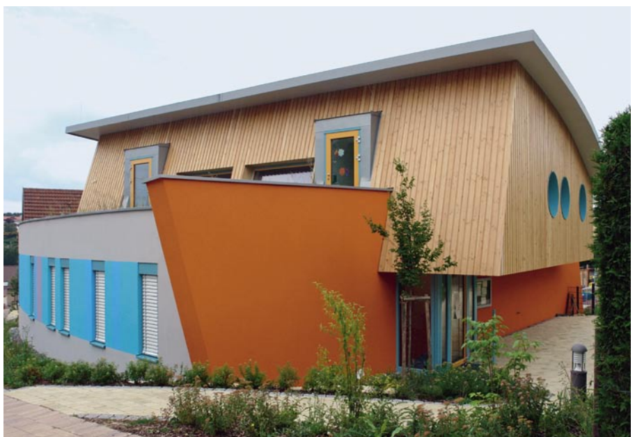
Beispiel Plusenergie-Kindergarten mit Seniorentreff in Wiernsheim, Massivbau mit Holzverkleidung, Architekt Alfred Raible, Kornwestheim
