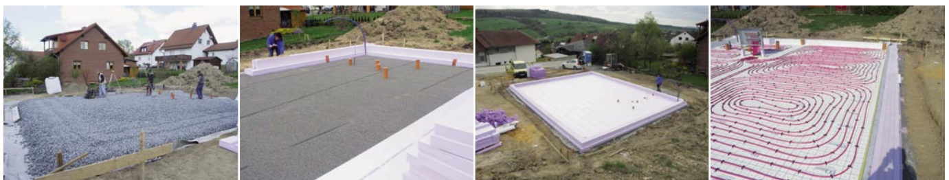
Erstellung der Bodenplatte in Körle: Erste Schicht mit Blähglas-Granulat, darauf die XPS-Dämmung und die Stahlbetonbodenplatte mit Heizschlangen. Auf deren geglättete Oberfläche wird der Oberbodenbelag direkt verlegt.
