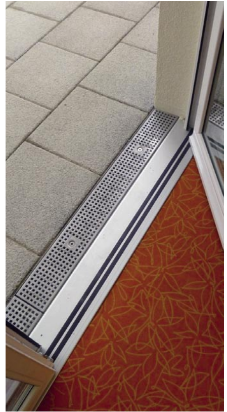
Bild 28: Schwellenfreier Übergang mit Lochblechabdeckung
