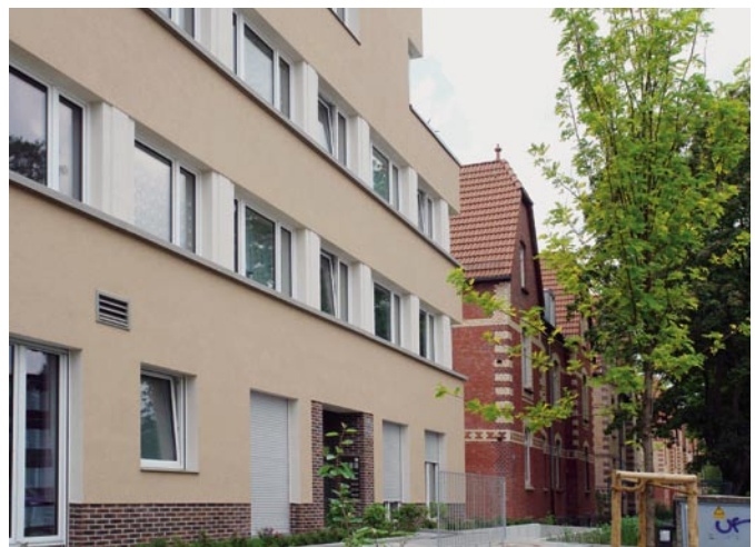
Straßenansicht Idsteiner Straße
