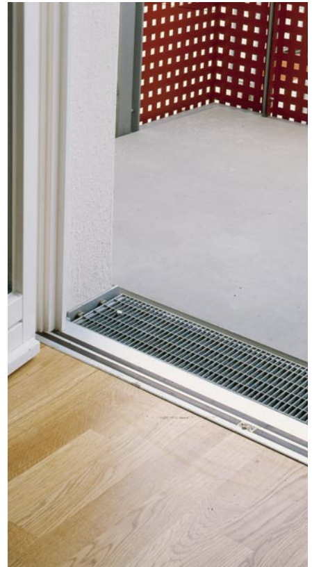
Bild 30: Schwellenfreier Übergang mit vorgelagerter getrennter Balkonplatte
