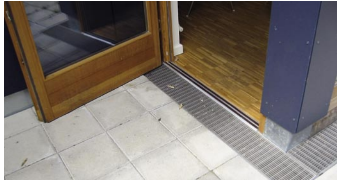
Bild 25: Schwellenfreier Terrasseneingang mit Rostabdeckung
