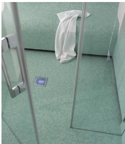
Bild 19: Schwellenfreie Dusche mit Punkentwässerung
