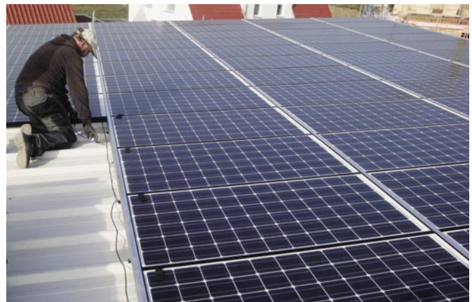
Passivhaus in Erlangen: Montage der Photovoltaikanlage
