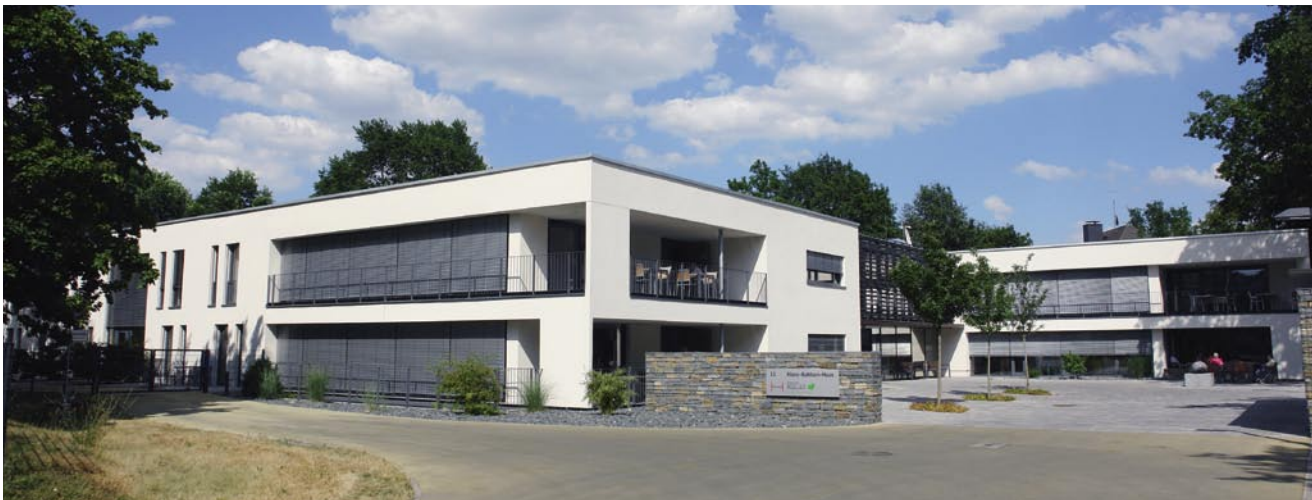
Altenheim Klaus-Bahlsen-Haus im Passivhausstandard, (pfitzner moorkens) architekten, Hannover
