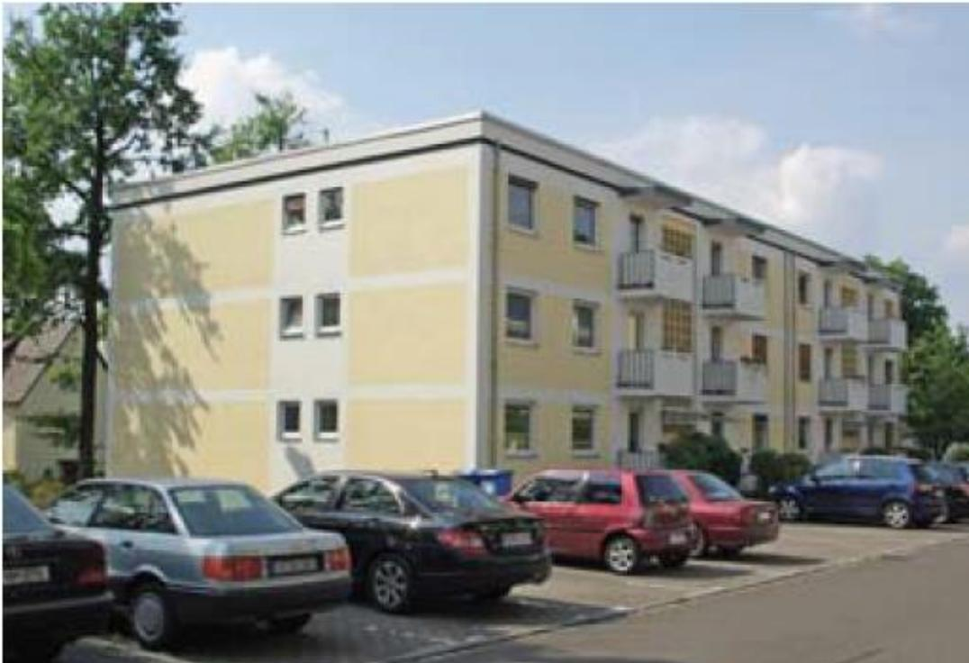
**WDVS mit 2cm Dämmung, nur die Fassade wurde neu gestrichen**
